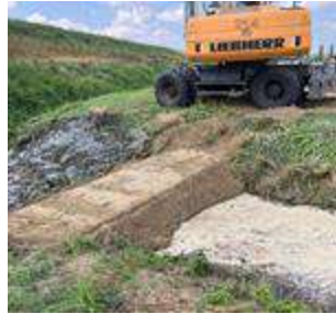
Riempimento del tratto di canale e costruzione della tura di valle del tratto
