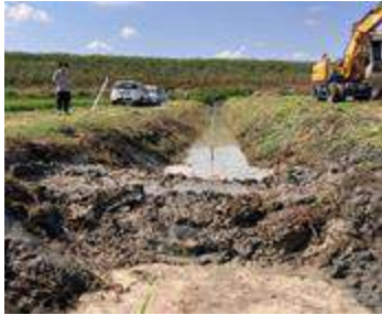
Costruzione di una tura in terreno argilloso a monte del tratto
